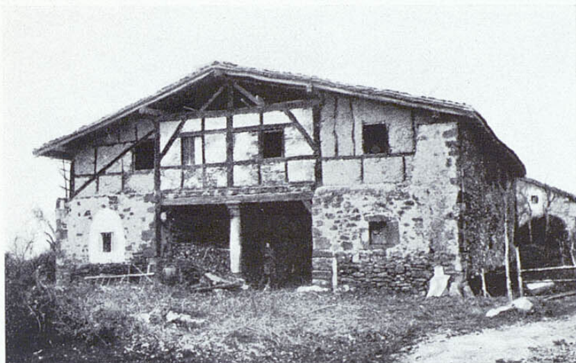
Caserío en Izurza ( Vizcaya )
