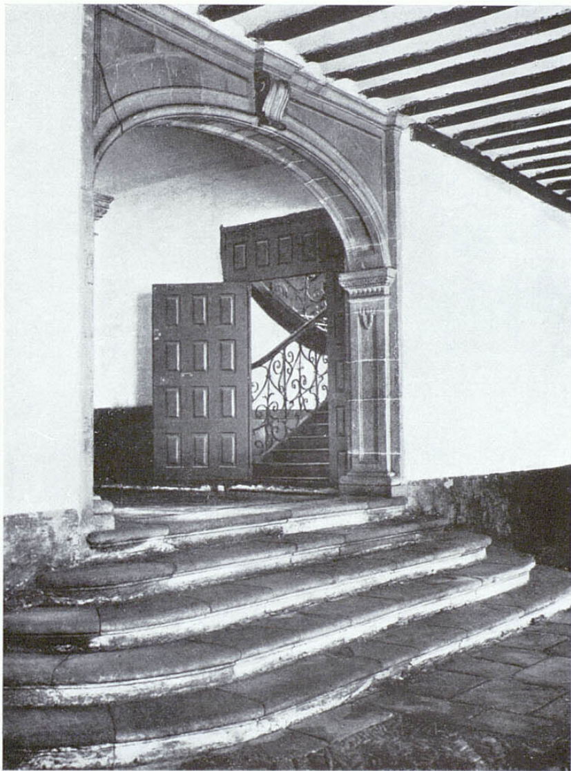
Entrada de la Casa de Yrizar, en Vergara ( Guipúzcoa )
