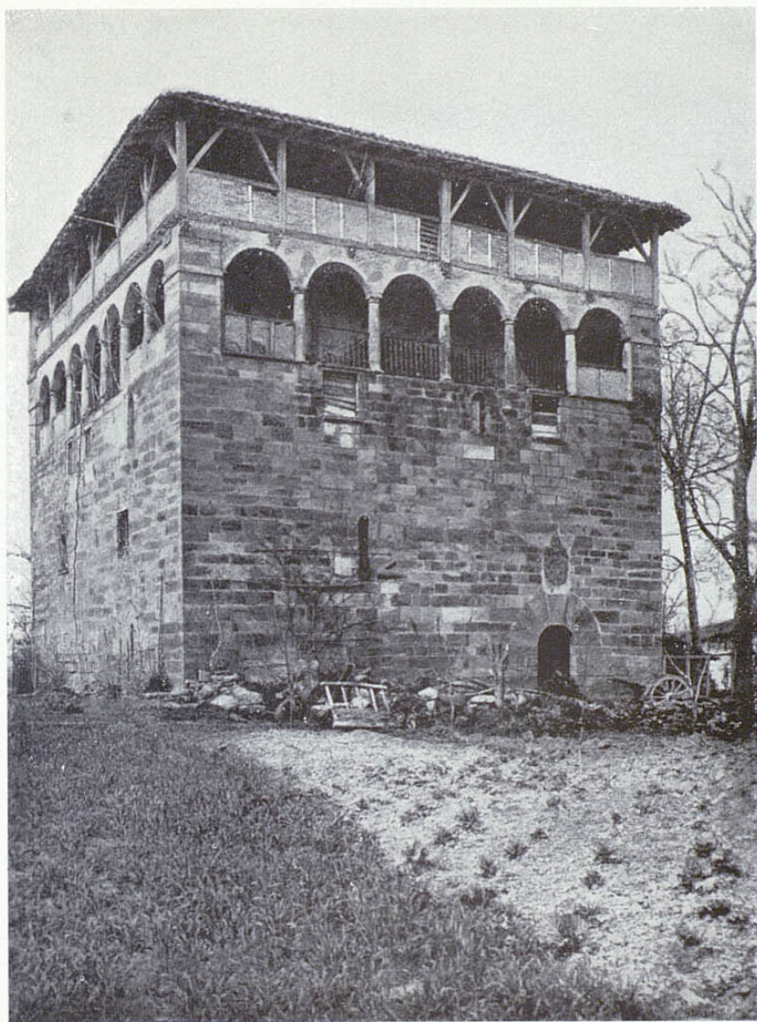
ABADIANO ( Vizcaya ).—Torre Muncháraz
