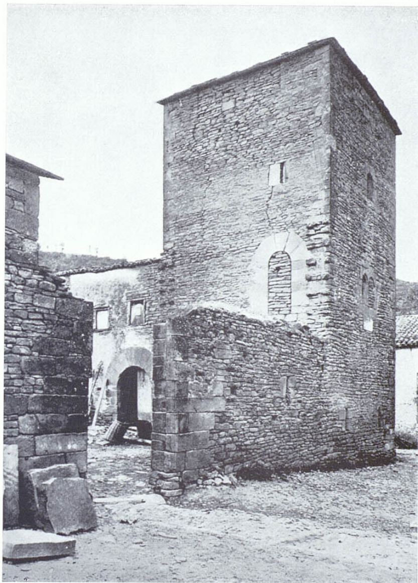
Torre en Salinas de Monreal ( Navarra )
